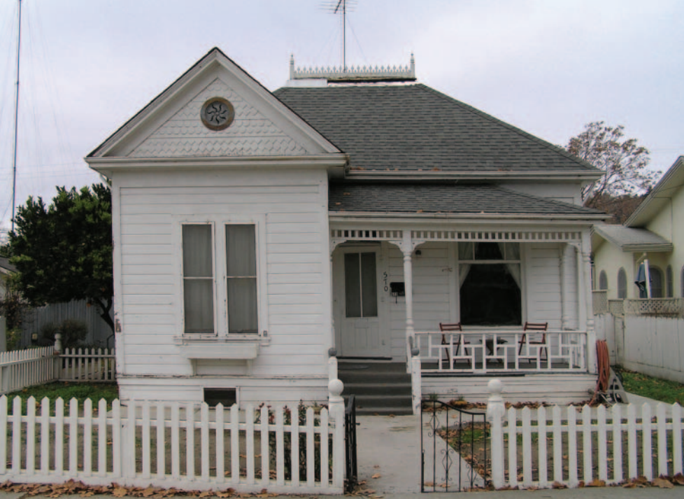
C 地点の傾いている家
