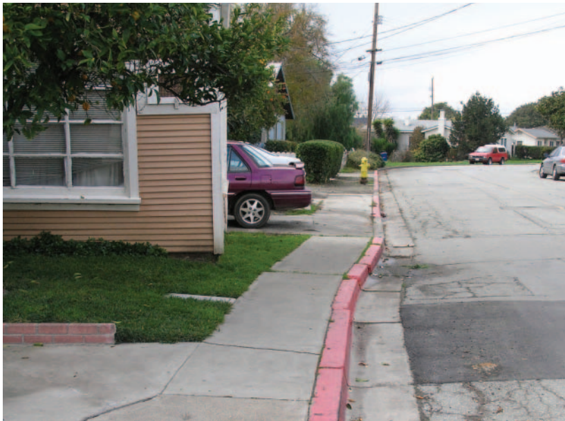
A地点の歩道と縁石の折れ曲がり
