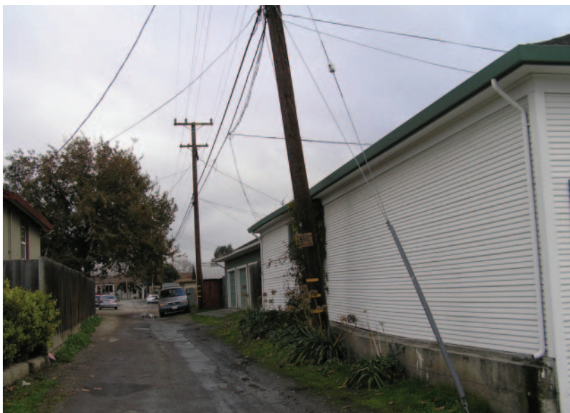
B地点の断層直上の建物の折れ曲がりと傾いている電信柱
